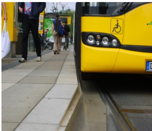
Rys. 9.7.1. Zalecane ukształtowanie krawędzi peronowej.
