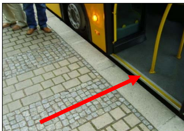
Rys. 9.7.3. Strefa wejściowa – inny rodzaj nawierzchni naprzeciwko pierwszych drzwi autobusu
