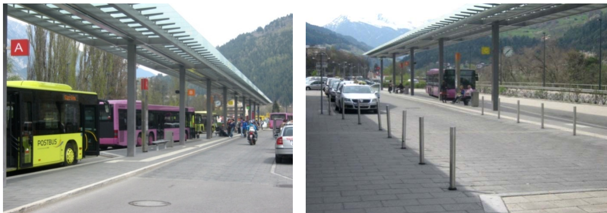
Rys. 12.2.1. Węzeł przesiadkowy przy stacji Landeck – Zams (Austria): przystanki autobusowe, postój taksówek oraz parking Kiss and Ride.
