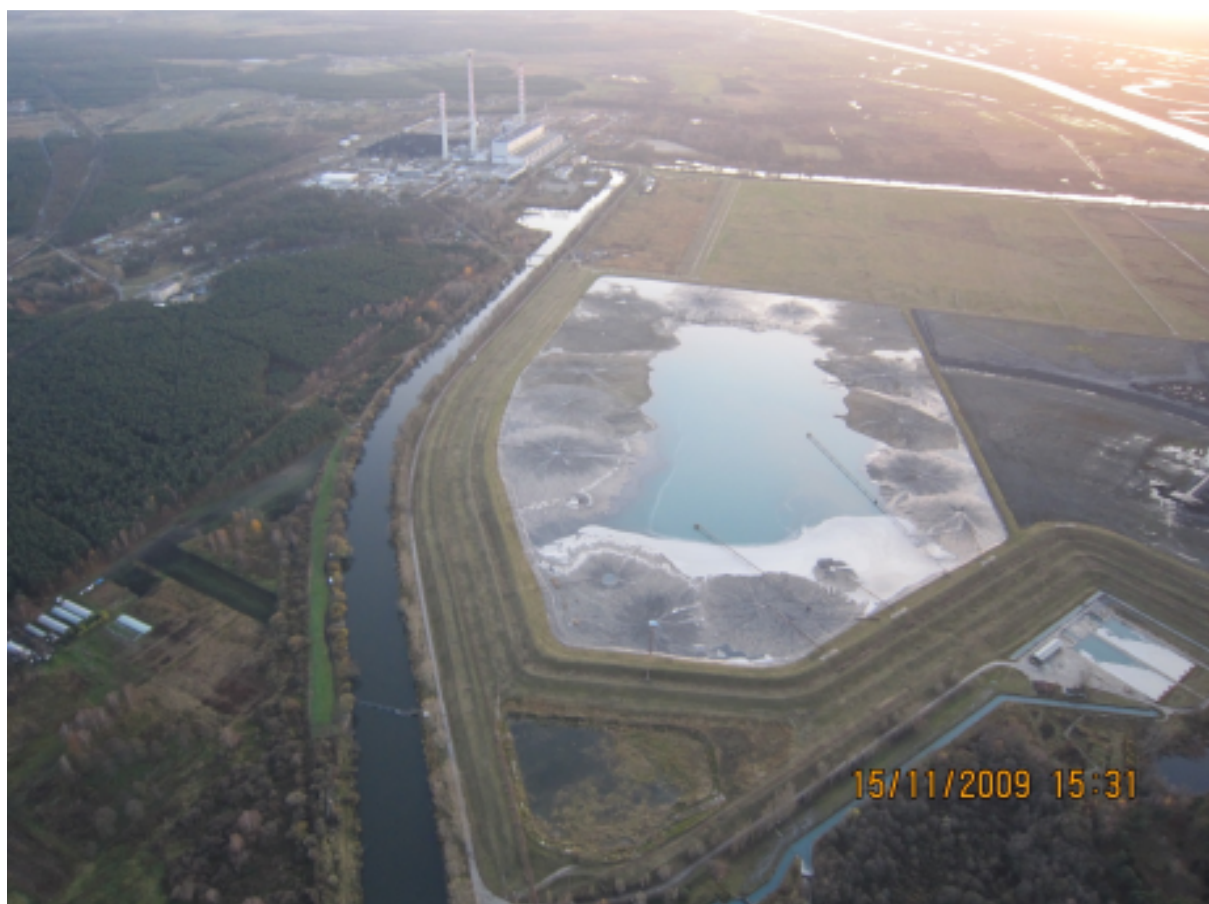
Zdjęcie 47. Kanał Ciepły przy Elektrowni Dolna Odra
